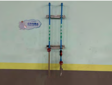
中水冲洗管道布置
