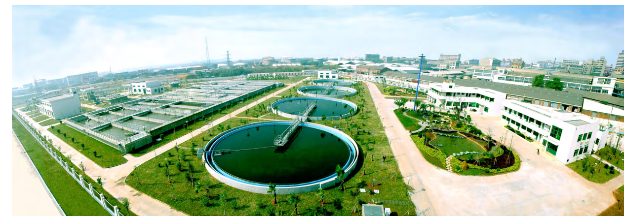
沙岗污水处理厂
