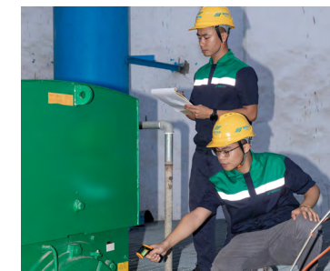
检查机器运行情况
