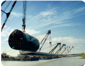
禅城区季华路西延东平河过河管安装
