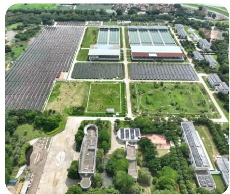
北江水厂分布式光伏发电设施航拍图
